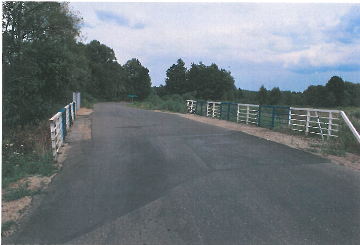
Fot. 1. Widok od strony południowej
