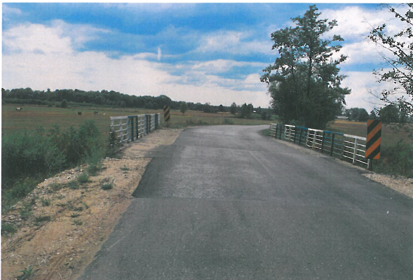
Widok ogólny mostu
